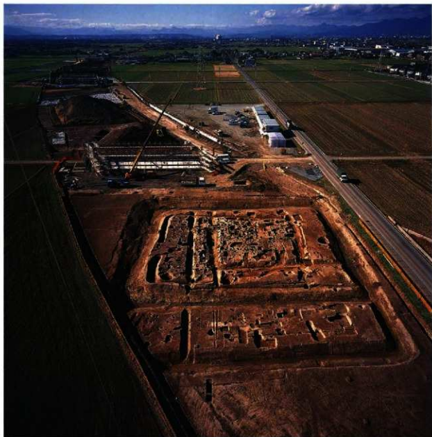
C区 屋敷跡から西側(高崎方面)を望む
