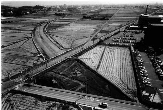
8区 全景 (北上空より太田市街地を望む)
