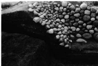
1. 墳丘：盛土断面Z-Z' 前庭西半付近（南東→）
