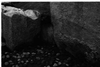
3. 石室：玄門南西隅 石組み状況（北東→）
