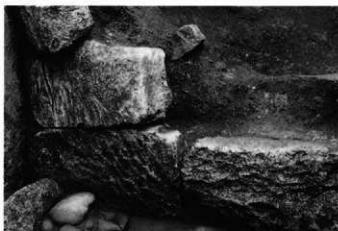
3. 石室：玄室西側壁 その2 (北東→)
