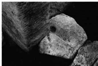
4. 石室：玄門部仕切石と東羨門との接合状況（北西→）
