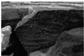
3. 墳丘：盛土断面W-W' (北東→)
