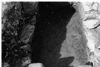
4. 石室：玄室 床石除去状況 (南→)
