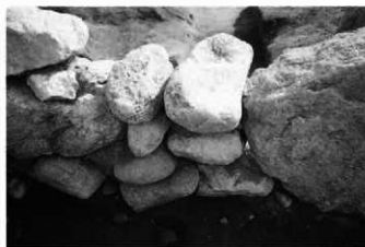
7. 石室：玄室東側壁石積み状況（西→）
