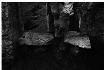
2. 石室：玄門部仕切石 解体状況（南東→）
