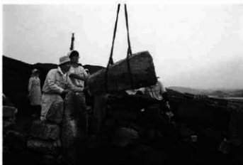
6. 石室：解体調査風景（南西→）
