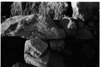
5. 石室：羨道天井石高架時の背面状況（南東→）
