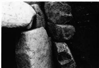
1. 石室：玄室西側壁 その1 (北東→)
