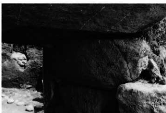
6. 石室：東側羨道側壁／天井石接地部（南→）
