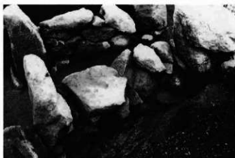
6. 石室：羨道 東側壁石材の背面状況 (南東→)
