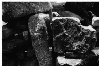
6. 石室：東玄門背面の石積み状況（北東→）
