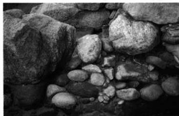
8. 石室：玄室東側壁石積み背面状況（東→）
