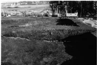
1. 墳丘：盛土断面g-g' 石室北側（西→）
