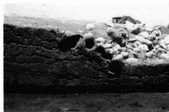
8. 墳丘：盛土断面 a-a' 東端石部 (南東→)
