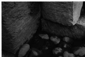
7. 石室：玄室南西隅部（北→）
