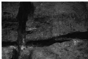
3. 主体部：床面断面G-G' 東半（南東→）
