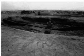
8.石室前土坑：張り床断面E-E'（西→）
