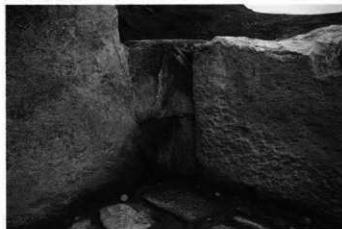
2. 石室：玄門北東隅 石組み状況（南西→）
