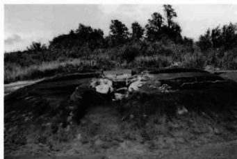
7. 墳丘：盛土断面P-P' (南→)
