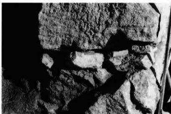
8. 石室：奥壁下端への裏込め設置状況（西→）
