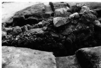
5. 石室：玄室 東側壁の背面状況（東→）
