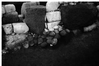
6. 石室：東玄門付近の側壁背面状況（南東→）
