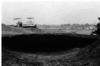
3. 周堀：覆土断面D-D'（西→）
