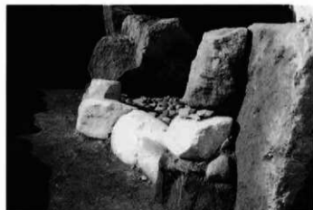
8. 石室：玄室西側壁付近の側壁背面状況（南東→）
