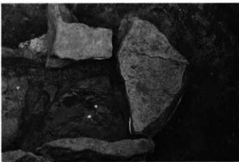
4. 第1主体部：東側壁と床石の接合関係（南→）
