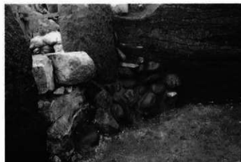
8. 墳丘：盛土断面c-c' 東玄門設置部 (南東→)
