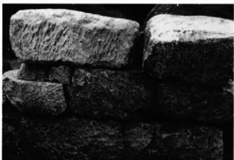
5. 石室：玄室西側壁 その3 (北東→)
