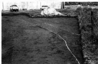
B区1面1号道全景(西から)
