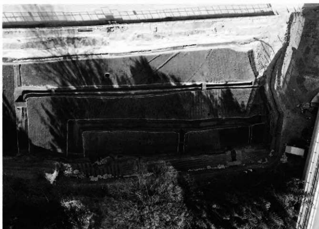
II区4面全景 上空より
