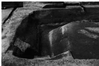
VI区3面1号溝折れ状況 西より
