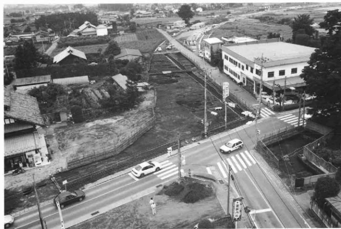
I区全景 斜め 北西から
