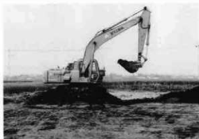
重機による表土掘削作業
