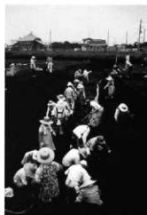
31号道構作業風景
