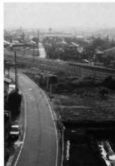
北区遠景 西方向
