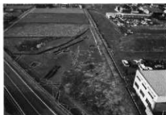
南区全景 南から
