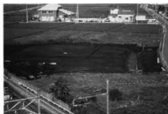
北区全景 西から
