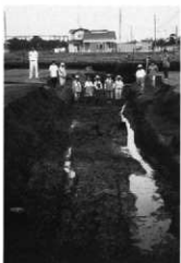
31号道構作業風景
