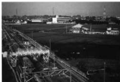
北区全景 西から
