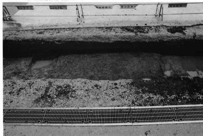
4. A区推定東山道（東から）
