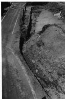
1号溝全景（南西から）
