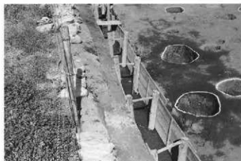
居宅掘立柱建物5区400全景(S→)
