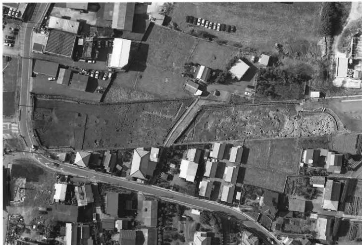
2区～5区縄文時代～古墳時代中期 全景(垂直)
