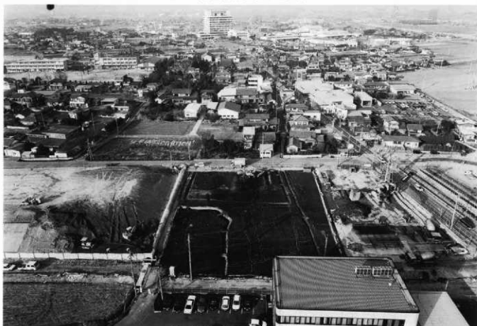
As-B下面C区西部全景（上空から）
