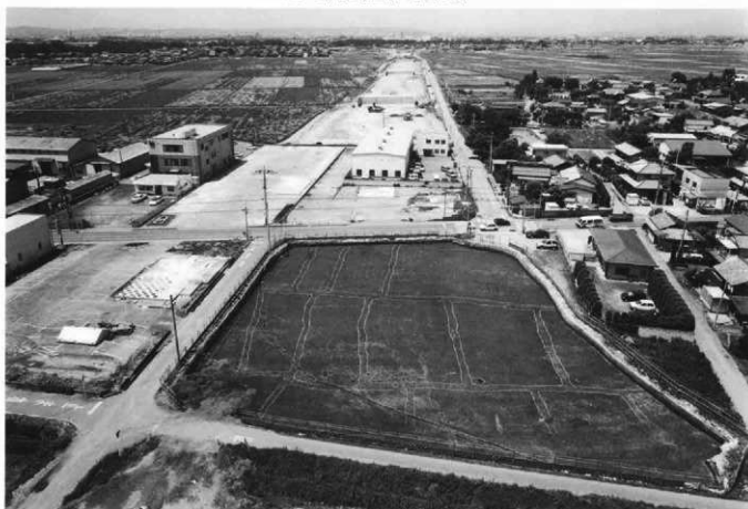
As-B下面A区全景（東上空から）
