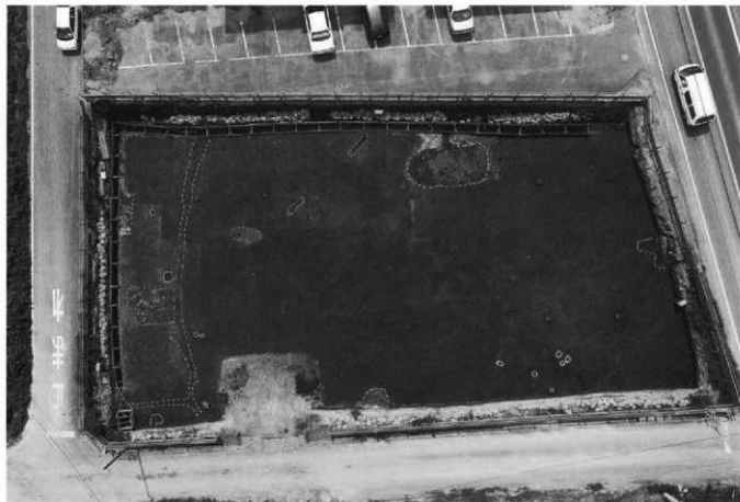
Hr-FA下面B区全景（上空から）
