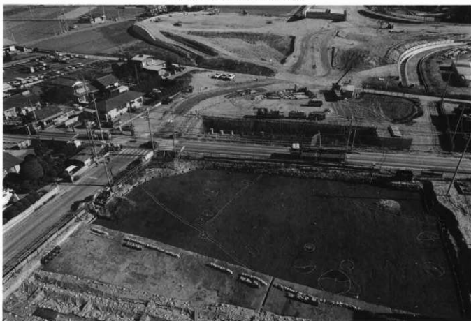
As-C下面C区東部全景（西上空から）
