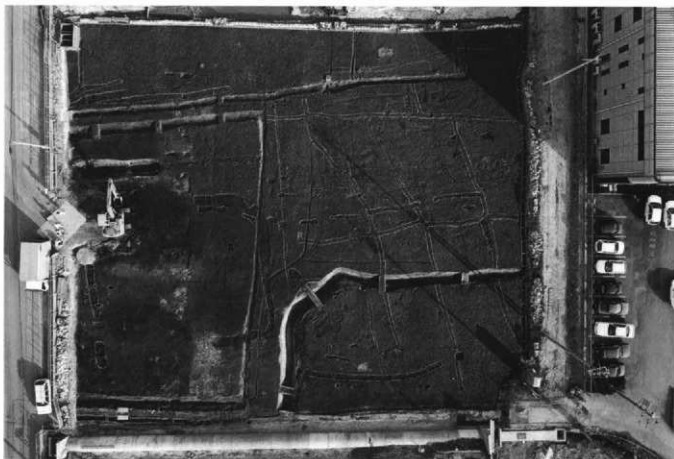
As-B下面C区西部全景（上空から）
