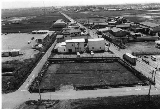
As-B下面B区全景（北上空から）
