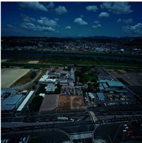
調査区及び元町工区全景（西から下郡方向を望む）
