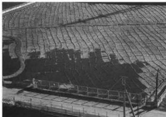
1. 給水実験 (北から) 黒色部分が水
