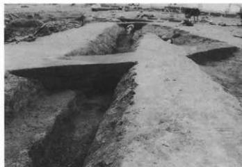
4. 258・271・272号溝 第244図SB (西から)
