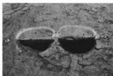
7号杭列 P-1セクション (西から)
