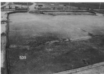
6. 509号溝全景 (南西から)
