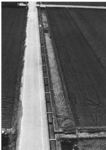
5. Aランプ A-2区平行部分 (南から)
