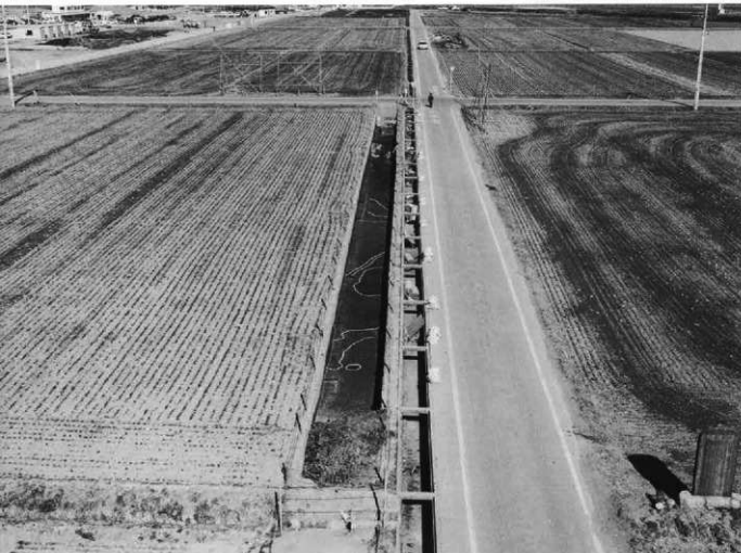
1. Aランプ B区平行 (南から)
