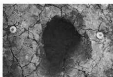
3号杭列 P-5 (南から)
