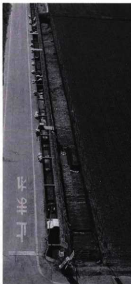
Aランプ全景（北から）
