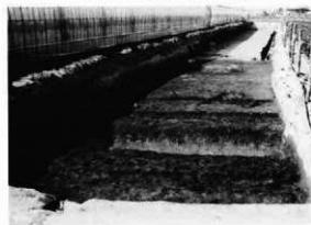
F区取り付道 第2面 全景
