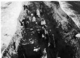
B区 第1面 1号溝杭の出土状況
