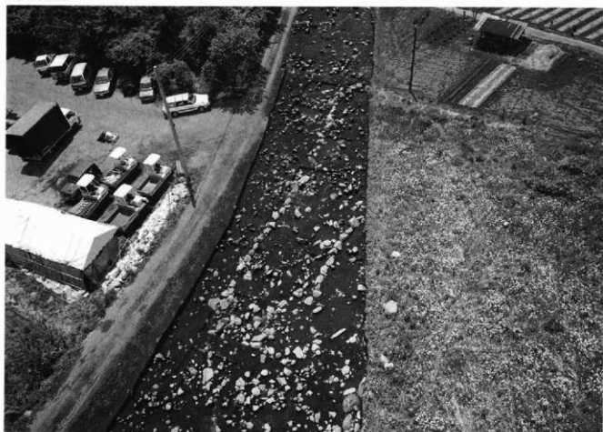
5区列石(上位面)全景(空撮・東から)
