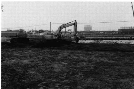
下阿内老町畑遺跡1区 重機による掘削作業風景（南より）
