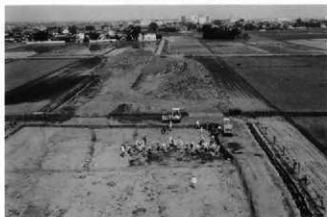
志町畑4区As-B除去作業 (西より)
