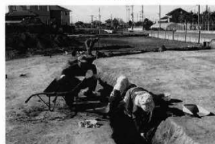
4号溝作業風景
