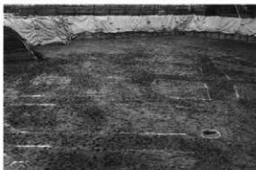
3 As-C混土上水田A区中央部 (東北より)
