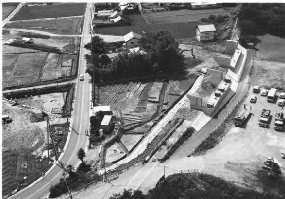
2 西横手遺跡群全景（東より）
