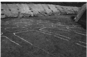
5 Hr-FA下水田A区東部 (南西より)
