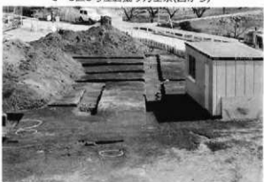
8 3区トレンチ調査状態(西から)
