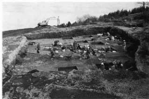
作業風景 (西より)
