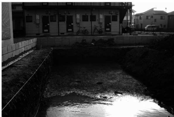
2 調査区西半部 完掘状況〔北東から〕
