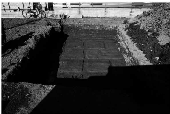
2 西調査区全景〔南西より〕
