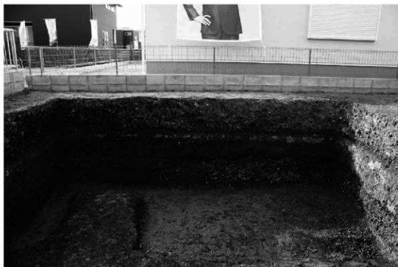
1 北西壁土層断面〔南東より〕
