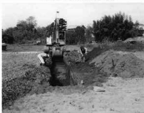
F区試掘 (南)
