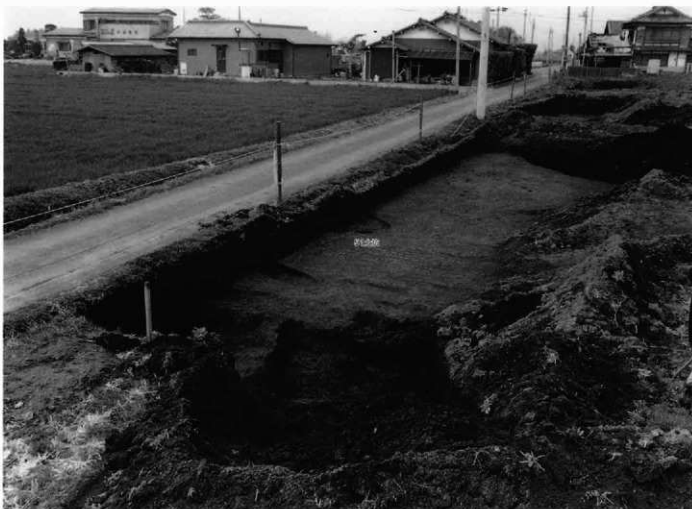
①支用1号の東側全景（北東から）
