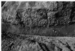
堀切頂部中央付近 (北西より)
