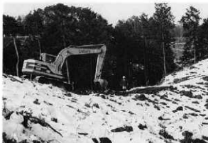
建設機械による表土除去（一つ尾根調査区）
