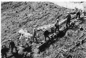
堀切南斜面掘削及び土運搬状況（北東より）
