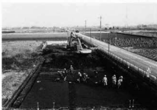
As-B下水田調査風景 (西から)
