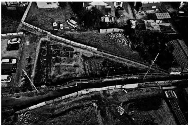
(2) J 地区全景(南から)
