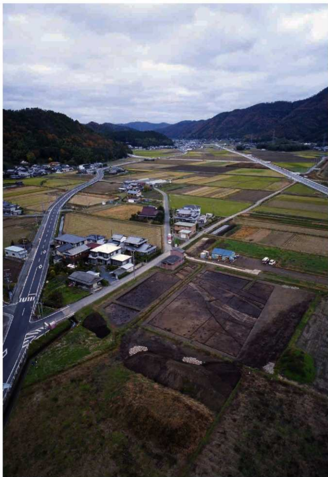
調査地遠景(南東から)
