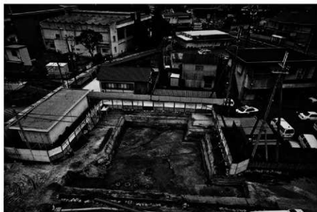
(2) 4・6トレンチ空中写真 (南から)
