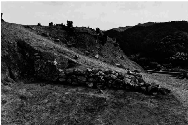
(2) 曲輪 3 石積 S V10 (北から)
