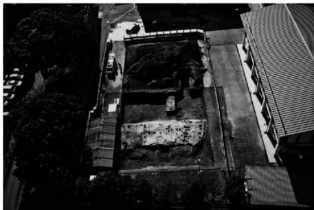
(1) 北半部空中写真(北から)
