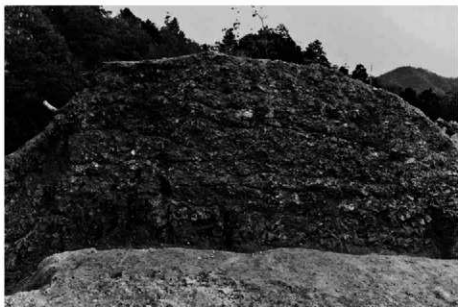
(1) 曲輪1 土塁断ち割り(北西から)
