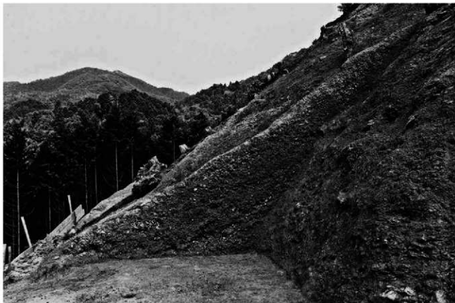
(2) 曲輪 6 切岸堆積土断面(南東から)
