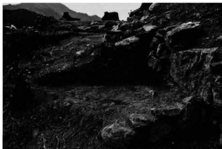
(3) 同北東虎口石段・石垣 S V 16 (北東から)
