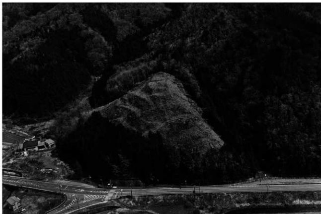
(2) 同(空中写真、西から)
