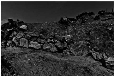
(2) 同石垣 S V 16(南から)
