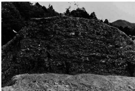
(1) 曲輪1土塁断ち割り(北西から)
