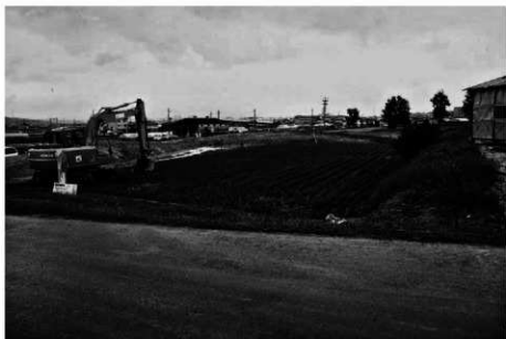
(1) D 5 地区調査前(北から)
