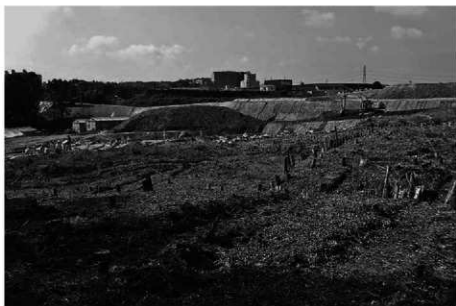
(3) 調査前全景(南半部、北西から)
