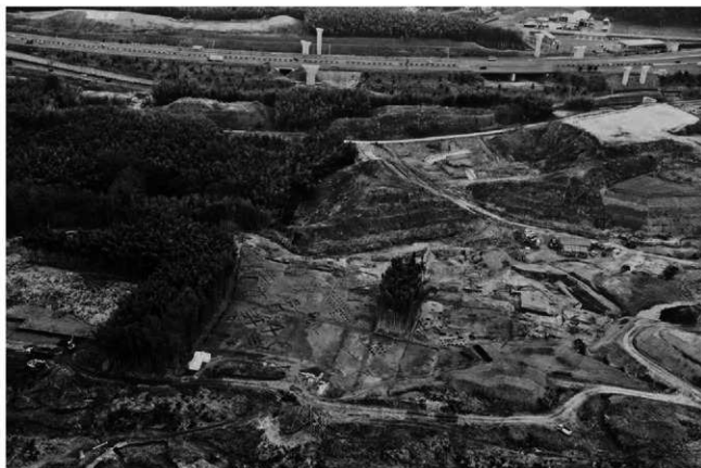
(2) 調査地全景(北西から)
