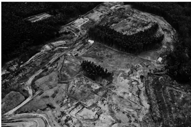
(2) 調査地全景(南から)
