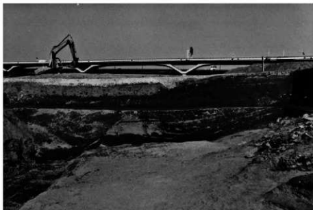
(1) E区北東壁断面(南西から)
