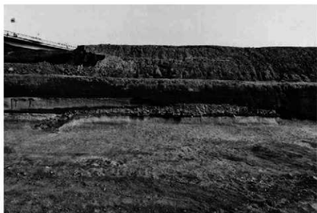
(3) C区水制S X 5 断面(北西から)
