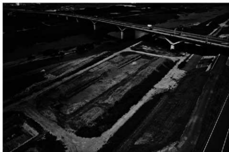
(2) C区全景(南から)
