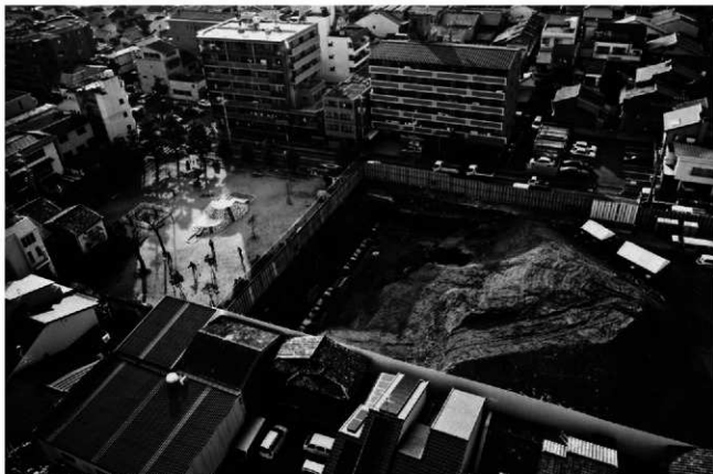
(1) 石垣 S W105 検出状況 (北東から)
