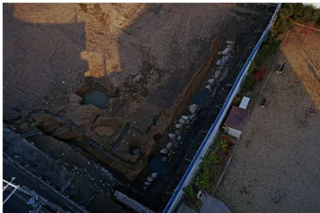
(2) 石垣 S W105検出状況(南西から)
