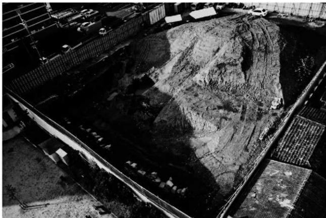
(2) 石垣 S W105 検出状況 (南東から)
