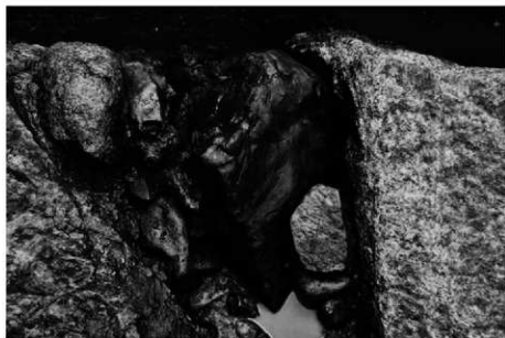
(3)石垣 SW105 石材 d 9 検出状況(北から)
