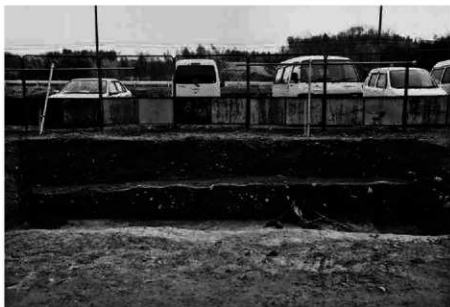
(3) 4 トレンチ東壁土層(北西から)
