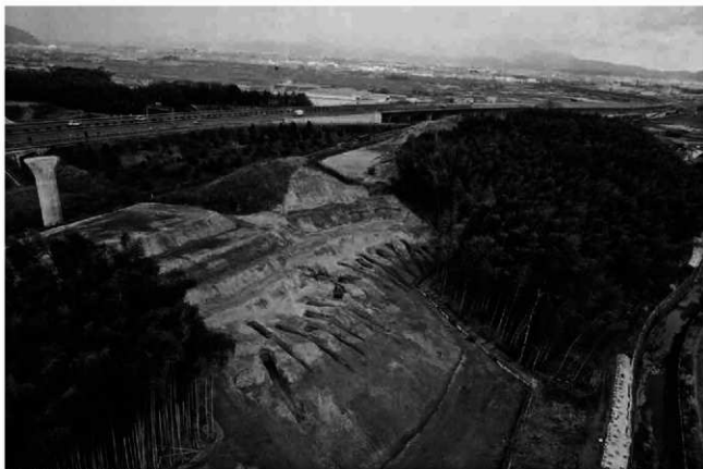
(1)調査地全景(南西から)
