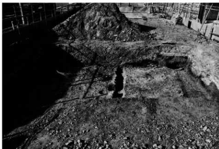
(2) 1 トレンチ中央部(南から)
