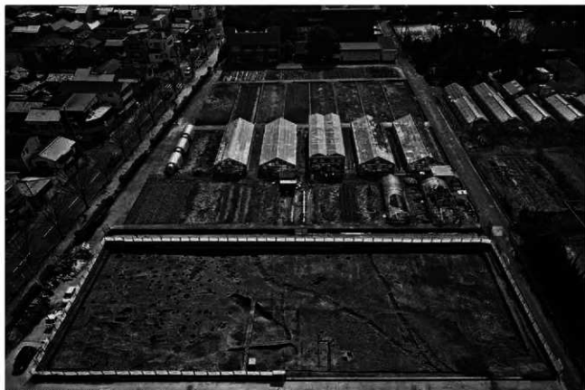
(1) 2区全景(空中写真 北から)
