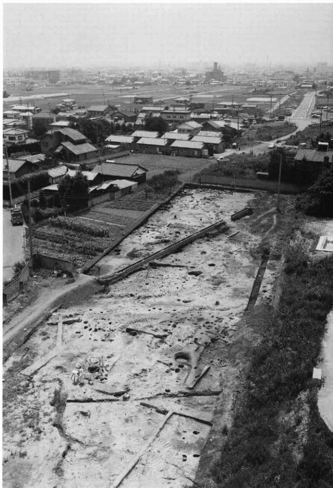
KS2区全景 北西より 遠景は高崎市街地
