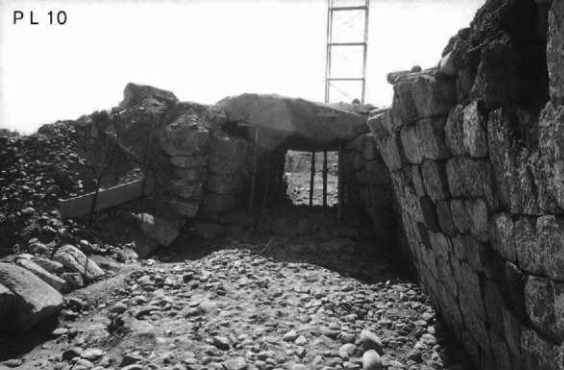
1. 玄室全景（奥から）
