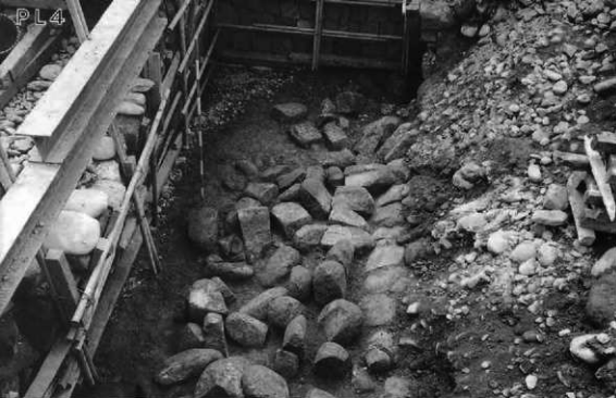
1. 玄室右壁崩壊状況
