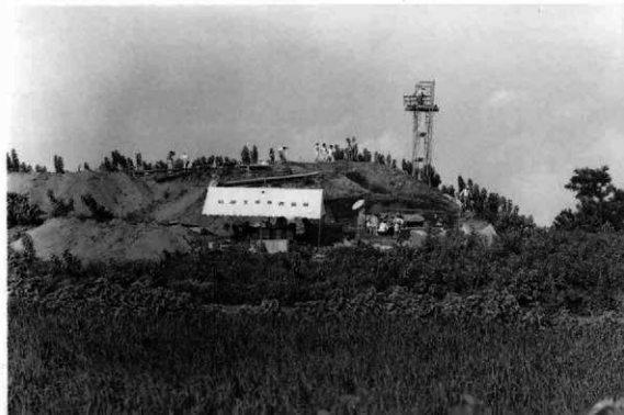
3. 後円部、石室の調査 第Ⅱ次調査 (西から)
