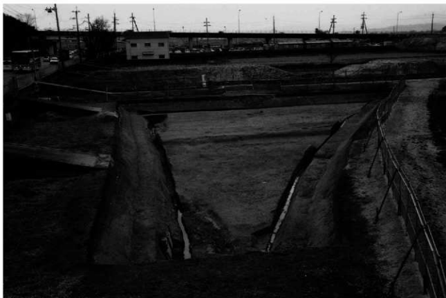
(1) E 地区全景(東から)
