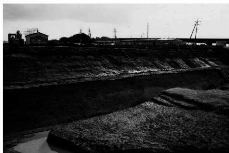
(2) C 地区南壁断面(北東から)
