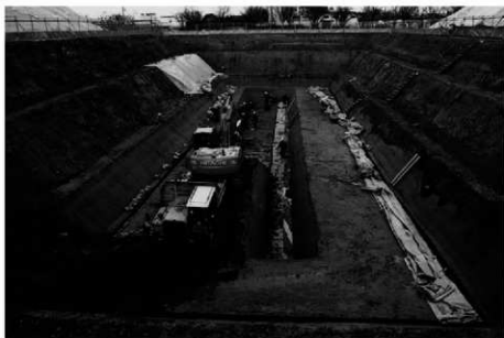
(2) 1 トレンチ作業状況(南から)
