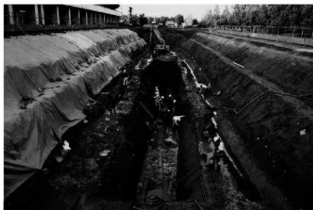
(3) 2 トレンチ作業状況(南から)
