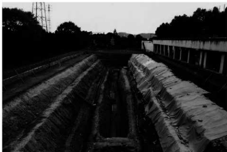
(1) 2 トレンチ全景(北から)
