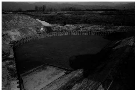
(3) 第3面全景(南西から)
