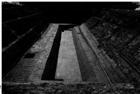
(1) 1 トレンチ最下層掘削状況全景 (北から)
