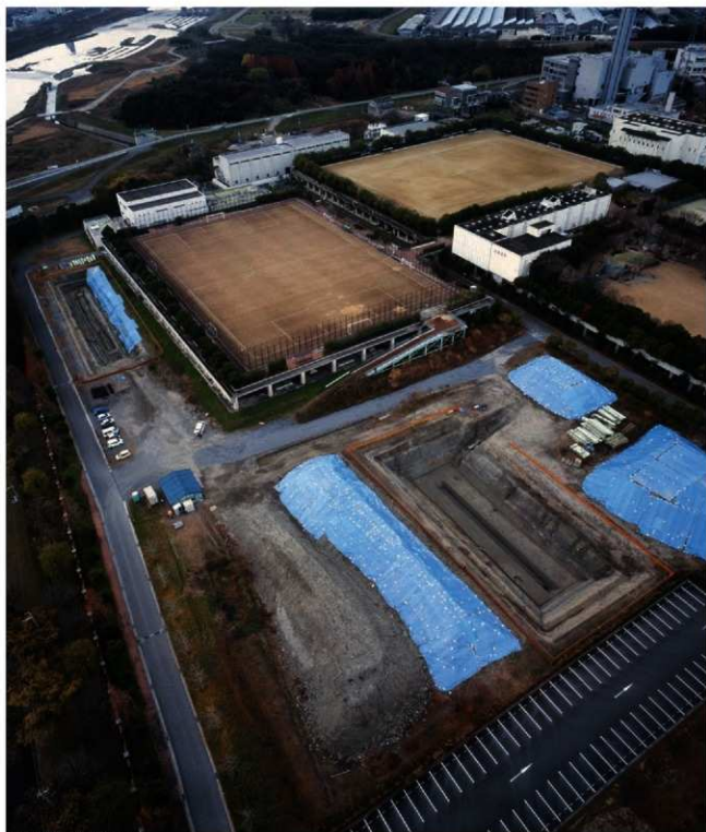
調査地全景(北東から)
