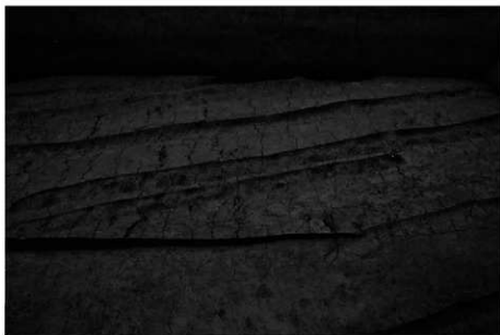
(3) 1 トレンチ溝状痕跡北部 (東から)
