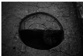
(5)掘立柱建物 S B02 柱穴 S P 202半載状況(南から)
