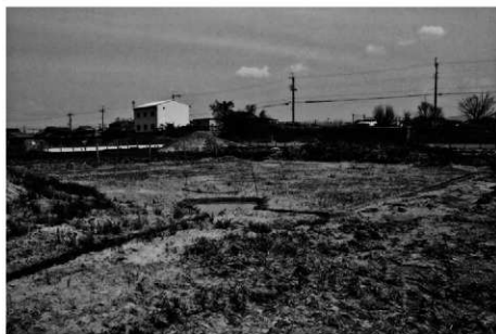
(3) 8トレンチ調査前全景 (南西から)
