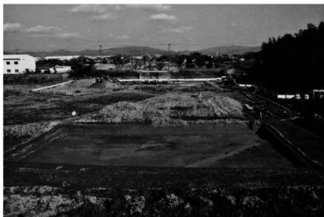
(2) 6トレンチ全景(西から)
