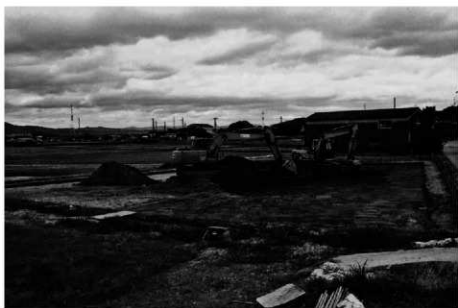
(3) Ⅲ区 4 トレンチ重機掘削 (北西から)
