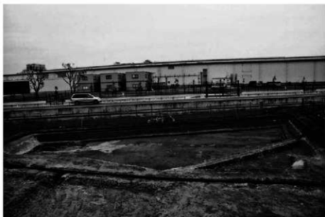
(2) Ⅲ区 3 トレンチ全景(南から)
