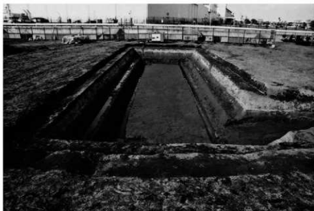
(1) II区3トレンチ全景(南から)
