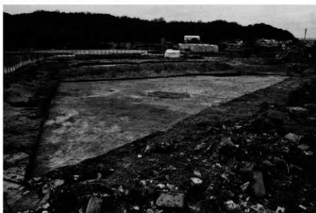
(2) 1トレンチ全景(東から)
