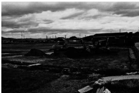
(3) Ⅲ区 4 トレンチ重機掘削 (北西から)
