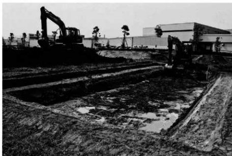
(1) I区4トレンチ重機掘削 (南東から)
