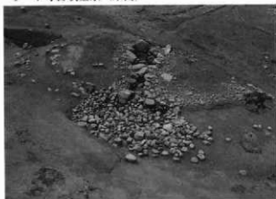
2 7号古墳石室前庭部崩落状態(東南)
