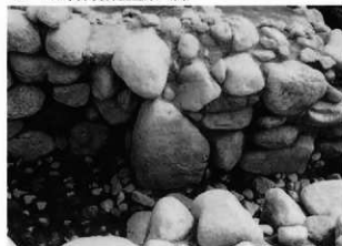
4 12号古墳石室右玄門 (北西)
