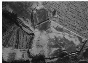
5 5・6・7号道全景 (中世・南上空)
