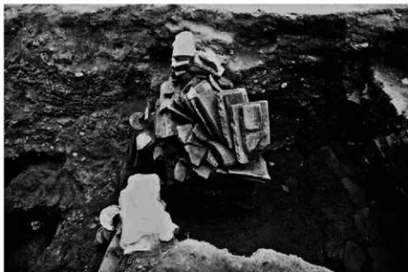
(1) 2 a号窯焚口崩落状況 (北から)
