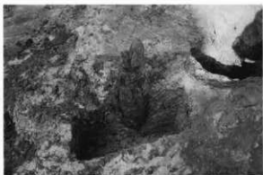
2. 1区1号入口道槽枕 3
