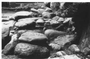
2 東側裏込め下
