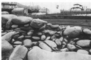
5 東側護道側壁
