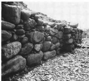
5 東側玄室と堀部
