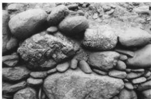
4 石室石材の割れ
