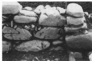
6 東側玄門および玄室側壁
