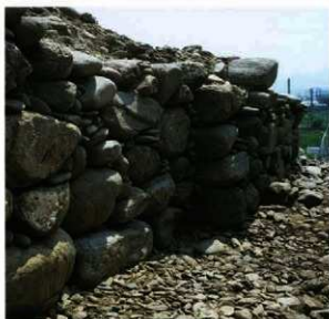
4 東側石室側壁
