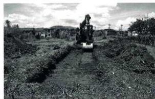
PL. 18 No.2試掘溝 機械掘削状況
