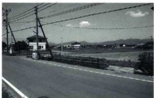
PL.6 調査地近景 (南西から)
